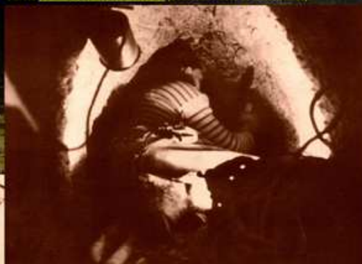
Creusement de la galerie d'évasion à l'Oflag XVII A. Une installation adaptée, électricité, wagonnet pour déblayer la terre, mini-pioches, réalisées par un lt. forgeron du camp. L'aération du tunnel était prévue grâce au Typhon II : Turbine de ventilation en bois et tôle réalisée par un prisonnier. © n°154 Journal de France les années 40 (Collection Musée de la Résistance).
